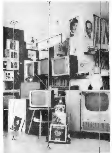
Die Auslagen eines Fachgeschäftes sind durch eine Feld-Raumschutzanlage gegen Diebstahl gesichert. Zwischen den von der Decke herabhängenden Drähten besteht ein elektrisches Feld, dessen Kapazität bei einer Annäherung sich verändert und den Alarm auslöst. Tagsüber können die Elektrodenseile in die Decke eingezogen und aufgespult werden
